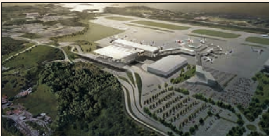
Den nye terminalen på Flesland er på 63.000 m 2 og skal etter planen ferdigstilles medio 2017.
