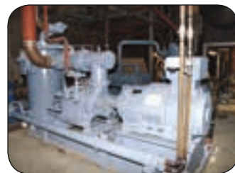
Ved sidste besøg hos Danish Crown kreaturslagteri i Holsted var køleanlægget under montage - ved det kommende besøg er anlægget sat i drift. - foto Eigil Nielsen
